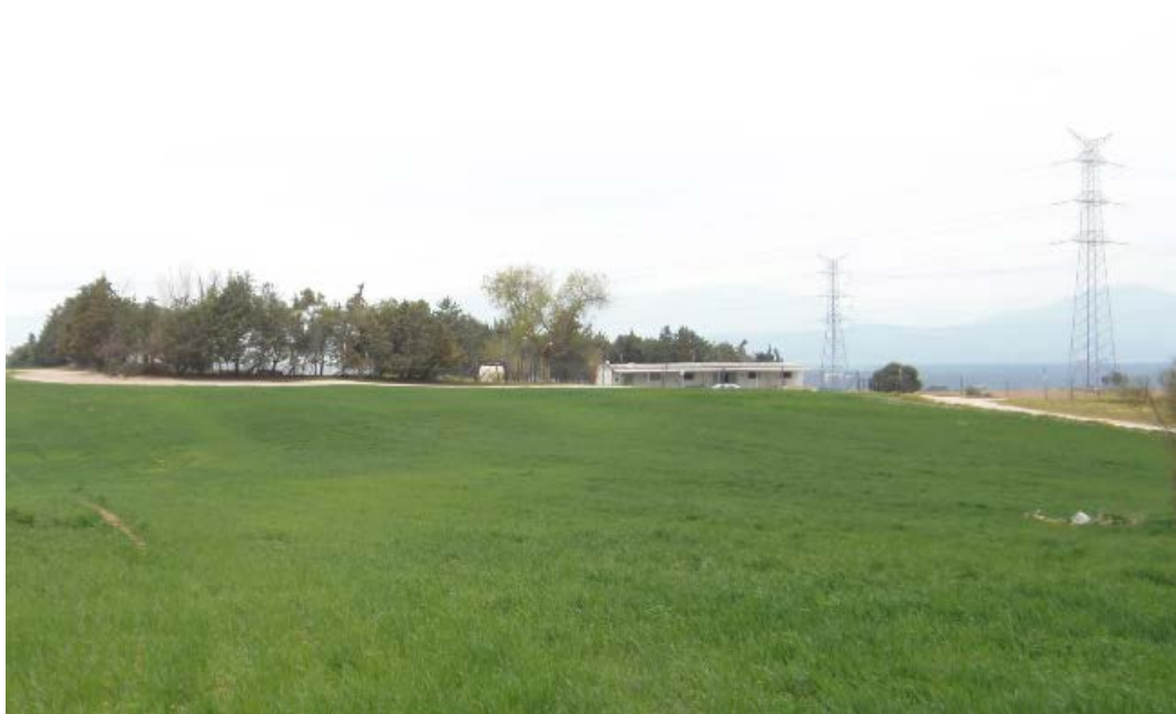
LAT por el límite norte del sector s-1. En esta zona se plantea un pasillo eléctrico
