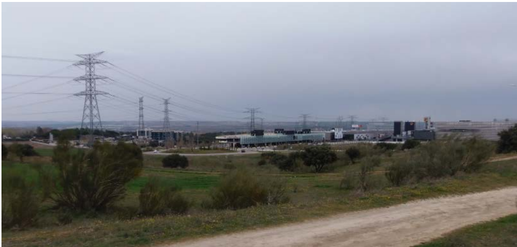
Zona norte del sector S-1 y línea aérea de alta tensión que va a ser trasladada
