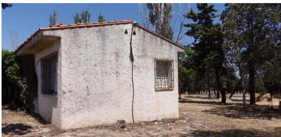
Detalle vivienda principal
