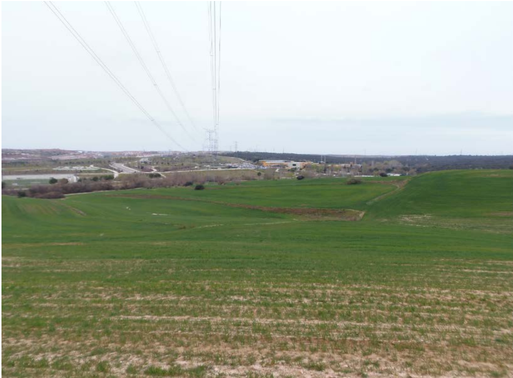
Vista del S-1 y S-2 desde el norte y en primer término, la LAT que va a ser trasladada
