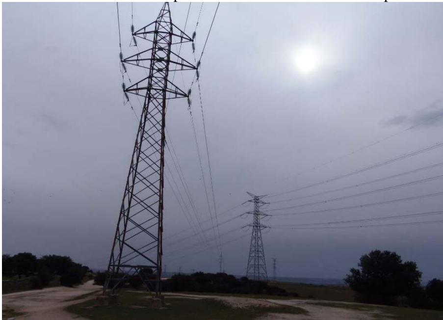
LAT por la zona norte del sector S-2. La línea de la derecha va a ser trasladada por el mismo trazado que la que se encuentra a la izquierda
