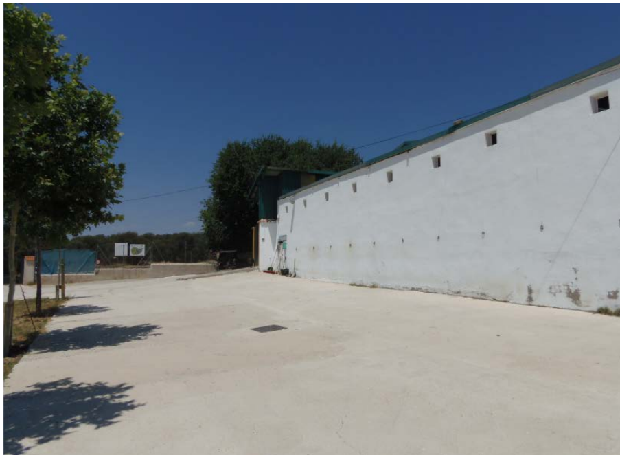
Aspecto exterior de la nave principal donde se encuentran las cuadras
