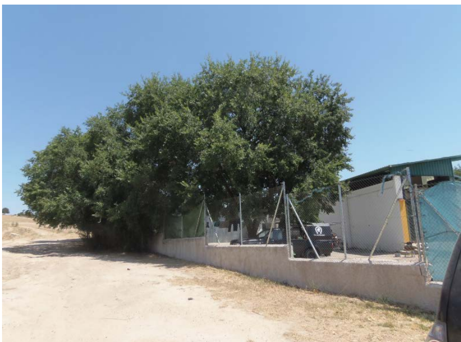
Aspecto del vallado exterior y de una de las naves
