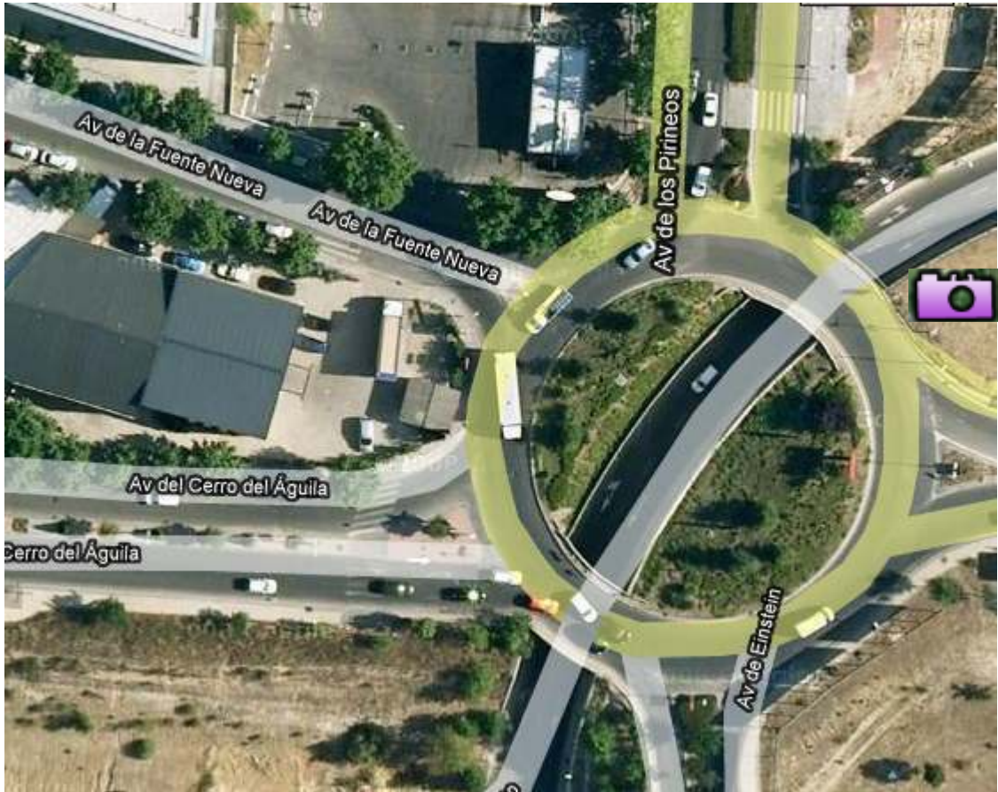
Cámara en Avda. Cerro del Águila con Avda. de la Fuente Nueva (Báculo: 10 metros)
